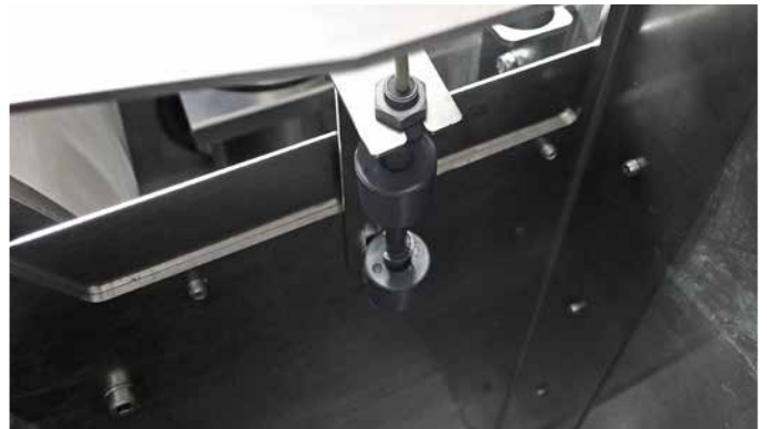
Filter mit und ohne Biokammer Schmutzwasserbereich vor der Trommel
